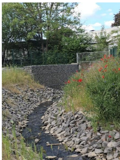
Renaturierter Bachlauf an der Siemensstraße
