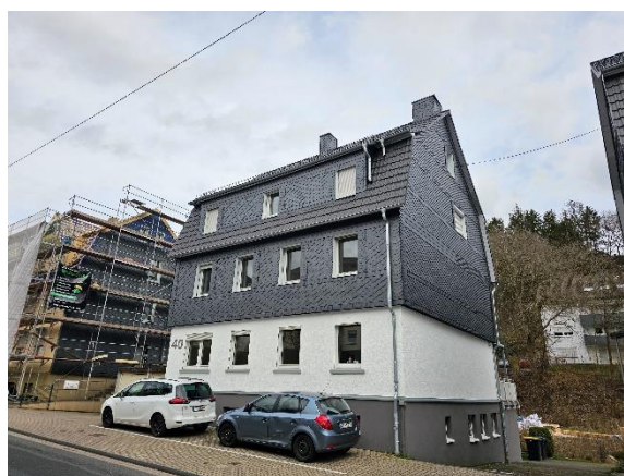
Blick auf die Siemensstr. 40, im Hintergrund haben die Bauarbeiten am Haus Siemensstr. 42/44 begonnen
