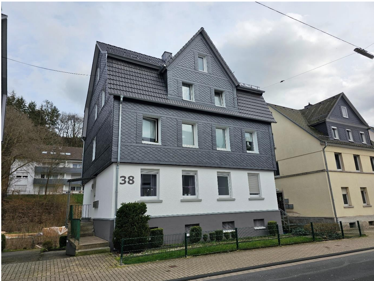
Siemensstr. 38 – Dach und Fassade wurden 2022 saniert
