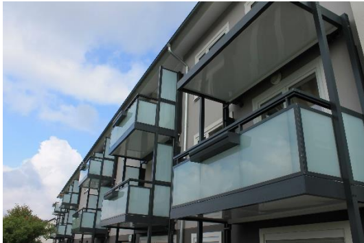
Neue Balkone in der Gießener Str. 27-37
